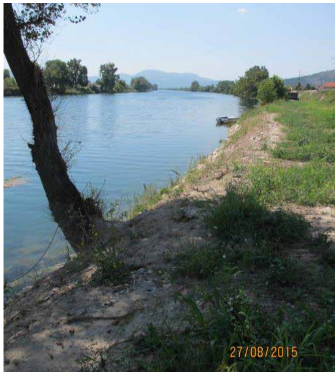
Slika 26: Stablo nije posiječeno te je uklopljeno u obaloutvrdu, a obaloutvrda je nakon izgradnje prekrivena zemljom. Rijeka Neretva. Autorska prava: HAOP.
