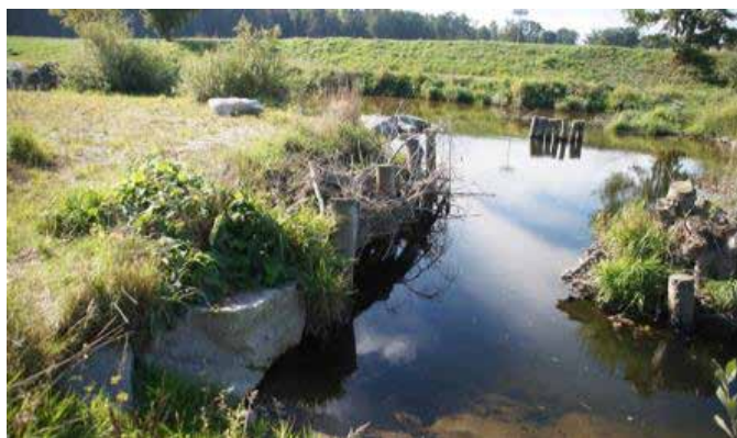
Slika 21: Komadi naplavnog drveta (granje) učvršćeni deblima. (Autorska prava: S. Guttman)
