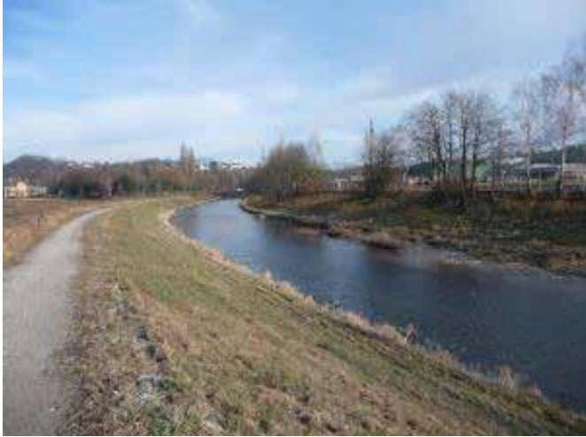
Slika 2: prijašnji tok rijeke Krems (lijevo). Povećani poprečni presjek rijeke. Omogućena je bočna erozija na područjima otkupljenim tijekom provedbe projekta (desno). Autorska prava: Blattfisch e. u., (2015)
