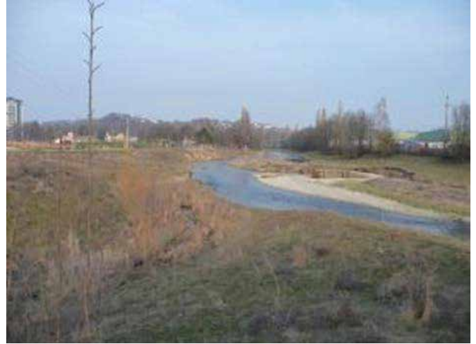
Slika 2: prijašnji tok rijeke Krems (lijevo). Povećani poprečni presjek rijeke. Omogućena je bočna erozija na područjima otkupljenim tijekom provedbe projekta (desno). Autorska prava: Blattfisch e. u., (2015)
