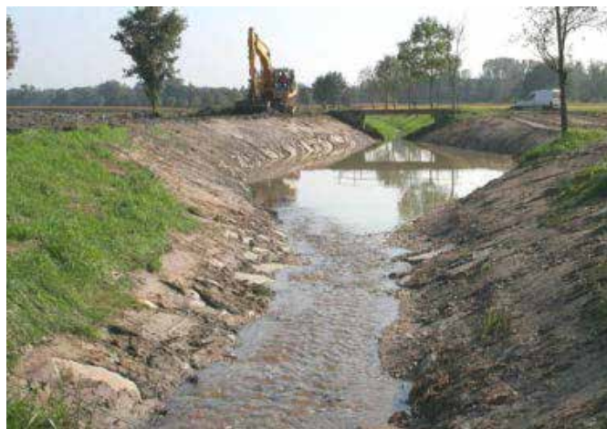
Slika 10: Sedimentacijski bazen u maloj nizinskoj rijeci ("Arbinger Bach") nakon radova uklanjanja sedimenta i nakon vađenja jedinki dunavskog vijuna (vidjeti sljedeću fotografiju). Autorska prava: Blattfisch e.u. (2015)
