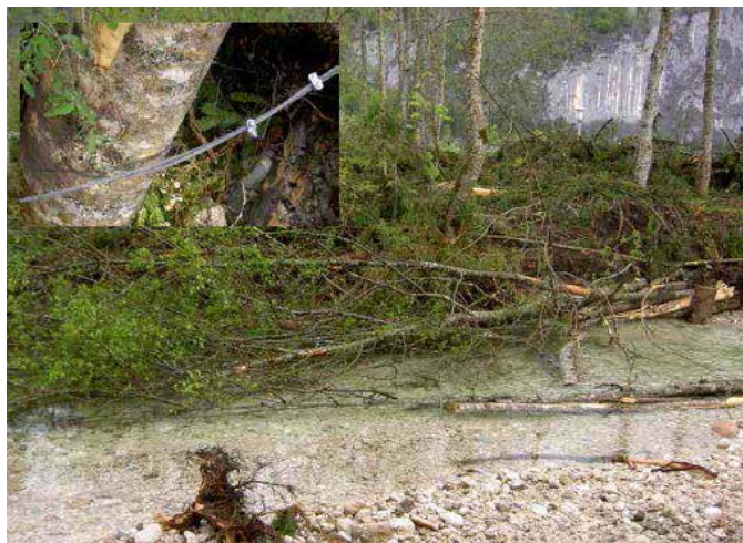
Slika 25: Stabla korištena za zaštitu vanjskog zavoja (učvršćena čeličnim kablovima). Autorska prava: Eberstaller Zauner Bueros (2015)
