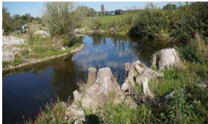
Slika 22: Panjevi s korijenjem iskorišteni za učvršćivanje vanjskog zavoja rijeke. (Autorska prava: S. Guttman), (vidjeti također sliku 33)
