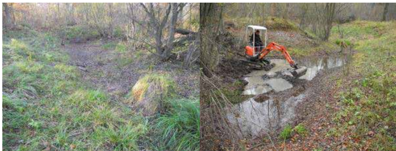
Slika 34: Lokva zapunjena sedimentom (lijevo) i uklanjanje sedimenta malim bagerom kako bi se očuvala okolna staništa (desno) Autorska prava: TB für Biologie, Werner Weißmair Lokvu sada nastanjuje 5 vrsta vodozemaca uključujući velikog vodenjaka ( Triturus cristatus ) http://www.herpetofauna.at/index.php/aktuelles/234-neue-tuempel-fuer-kammolch-co-stand-dez-2014
