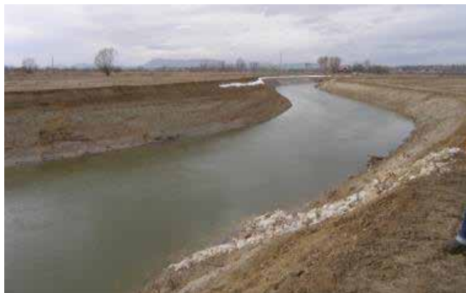
Slika 28: Loš primjer održavanja obalne zone. U potpunosti uklonjena vegetacija i ostavljeno golo tlo uzrokovat će daljnju eroziju i unos sitnog sedimenta u rijeku. Rijeka Bednja. (Autorska prava: HAOP.)
