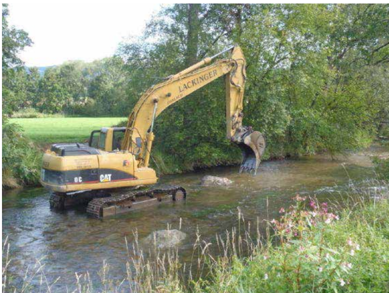
Slika 3: Veliko kamenje stavljeno je u rijeku kako bi se povećala raznolikost sedimenta/staništa za vrstu peš ( Cottus gobio ), slatkovodnu riječnu bisernicu ( Margaritifera margaritifera ) i druge vodene vrste. Kamene gromade težine su 1.5 do 2 tone. Monitoring je pokazao povećanje bogatstva vrsta, kvalitete ribljih populacija i raznolikosti staništa (Hauer et al., 2010., Hauer, 2012). Autorska prava: Christoph Hauer.
