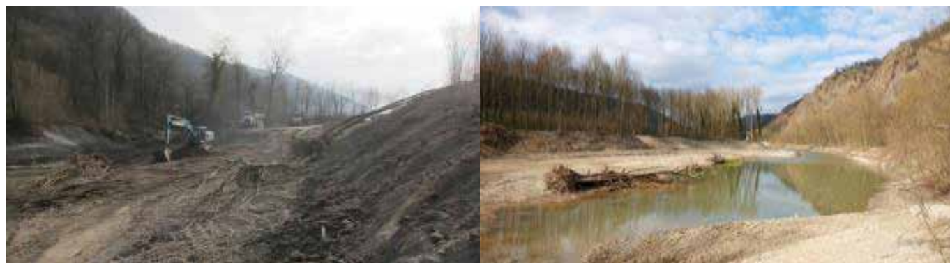
Slika 33: Tijekom iskopa (lijevo) i gotovo dovršeni radovi (desno) Autorska prava: Eberstaller Zauner Buros (2015)
