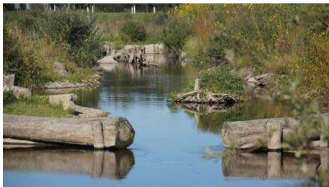
Slika 23: Debla korištena kao pera usmjerena nizvodno na obje strane rijeke. (Autorska prava: S. Guttman)
