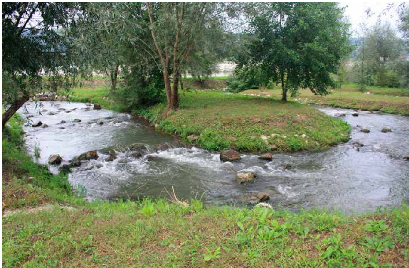
Slika 12: Riblja staza u obliku obilaznog toka; HE Blanca, Slovenija; Fotografija: HAOP
