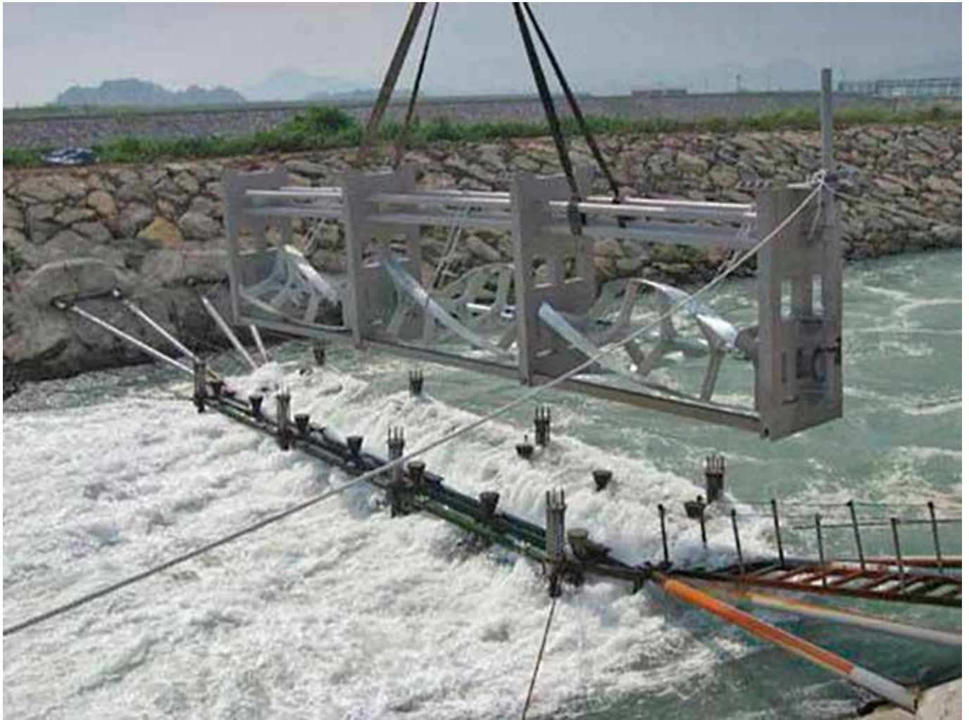
Slika 18: Lanac Gorlov horizontalnih turbina prilikom instalacije u Južnoj Koreji (Izvor: Guidance document on hydropower development and Natura 2000-Draft)
