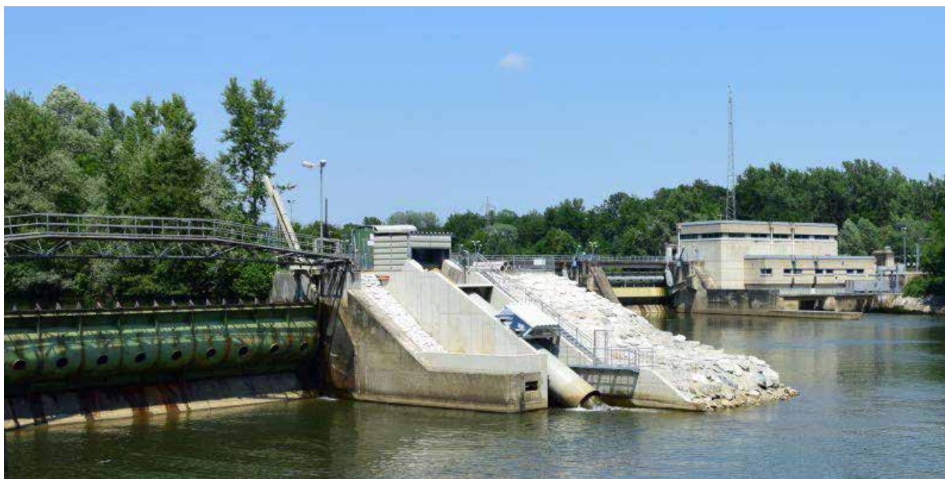
Slika 17: Arhimedova hidrodinamička pužna turbina; moguće su istovremeno uzvodne i nizvodne migracije; hidroelektrana Retznei, Verbund, Austrija, Fotografija: Hydroconnect
