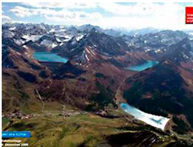
Slika 3: Reverzibilna hidroelektrana Kühtai; Tirol, Austrija; Fotografija: TIWAG
