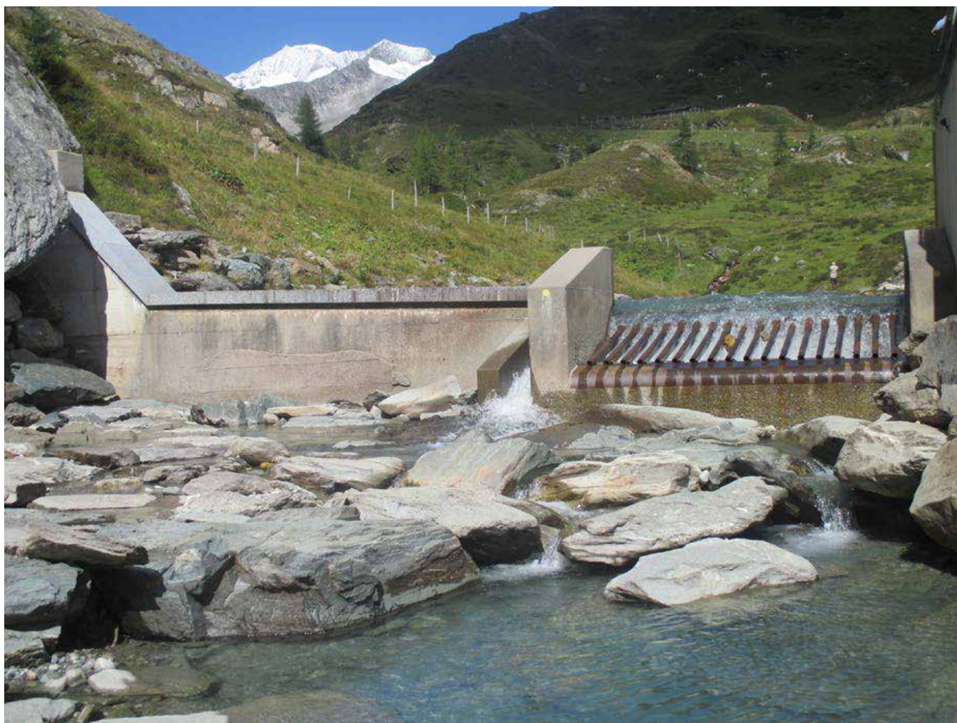
Slika 4: „Tirolski prag“, Dorferbach, Austrija; Fotografija: TIWAG – Tirolska tvrtka za proizvodnju i distribuciju električne energije
