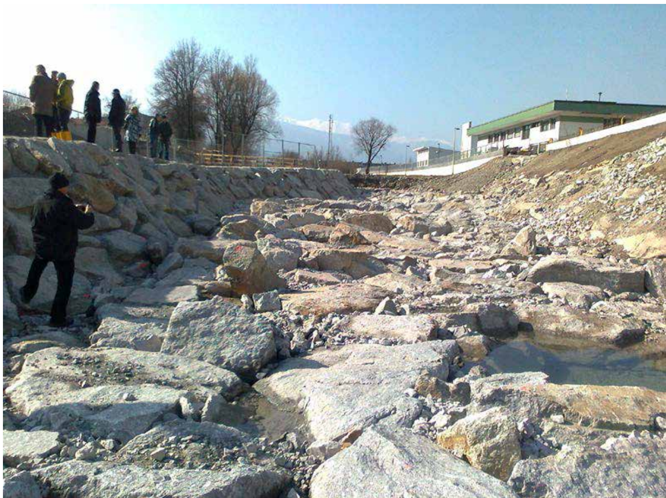
Slika 10: Riblja staza u obliku kamene rampe, u izgradnji; rijeka Sil, Tirol; Fotografija: Erhart D.
