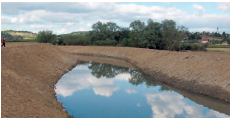
Slika 4. Kanaliziranje korita rijeke Bednje (foto: V. Hršak)
