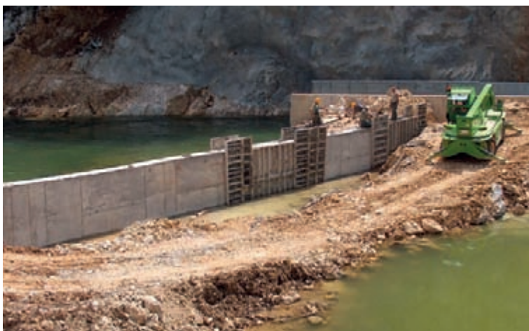
Slika 5. Gradnja brane na Dobri, Lešće (foto K. Fabrio)
