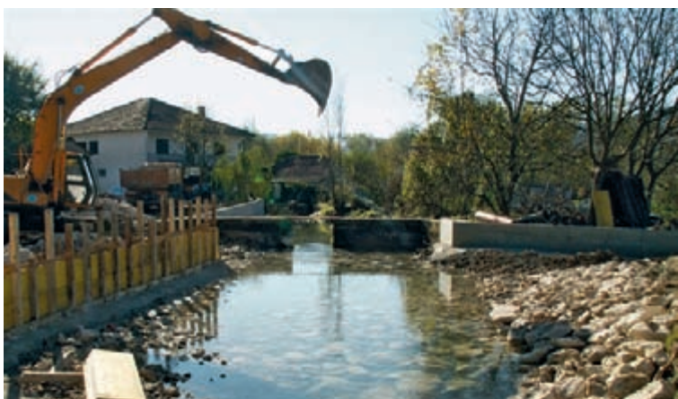
Slika 6. Betonizacija izvora u Polju Jezero
